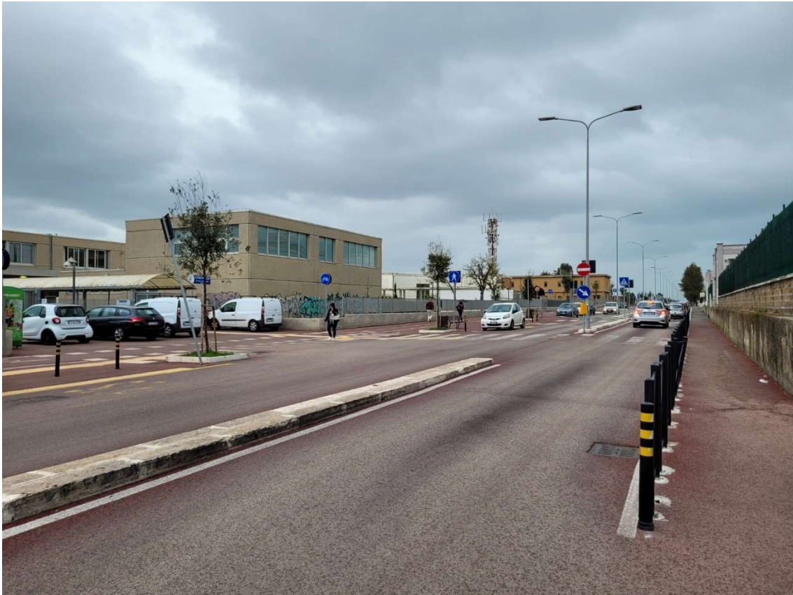
Fig. 2-15 Particolare Via Carlo Alberto Dalla Chiesa
