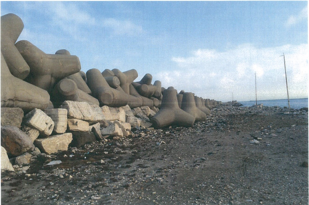
Foto 3.1 Tetrapodi fuori sagoma depositati lungo il molo Traiano
