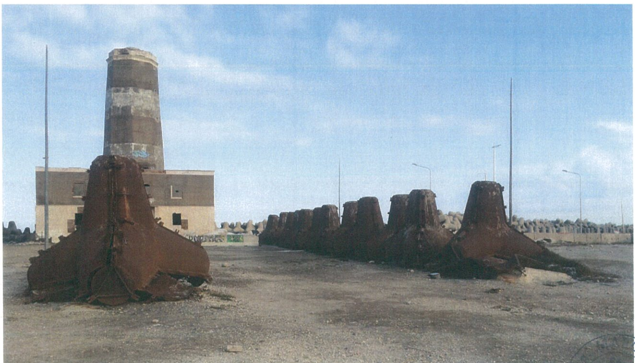
Foto 3.2 Casseforme metalliche tetrapodi in area Faro
