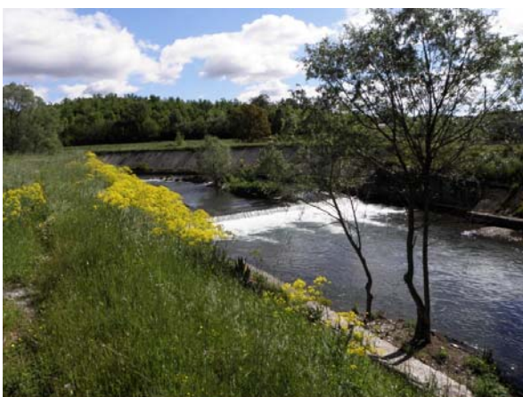
Sbarramenti sull'Agri (foto WWF Basilicata)
